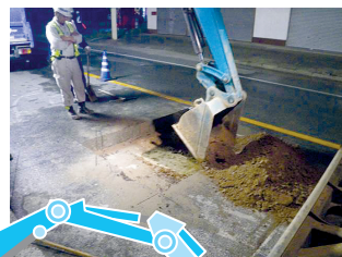
バックホウ による破碎例
