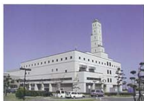
西部水処理センター
