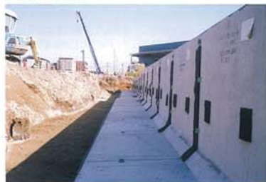
L型擁壁の設置
