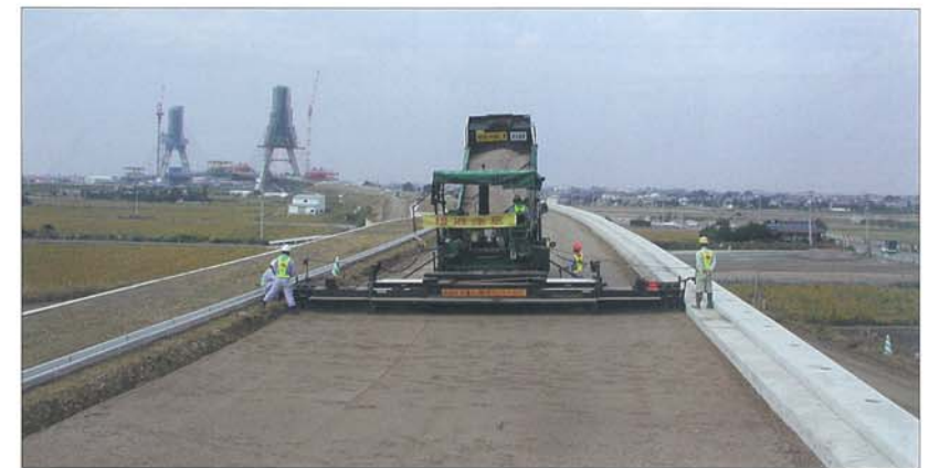
福岡208号 有明海沿岸道路 施工状況
