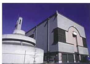
東部水処理センター
