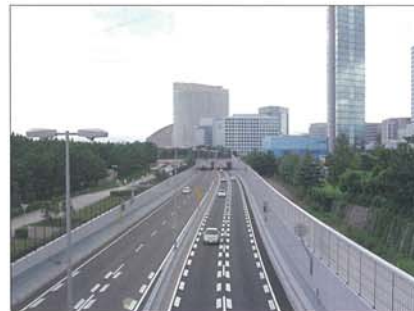
福岡都市高速道路1号線（百道）／半地下構造区間
